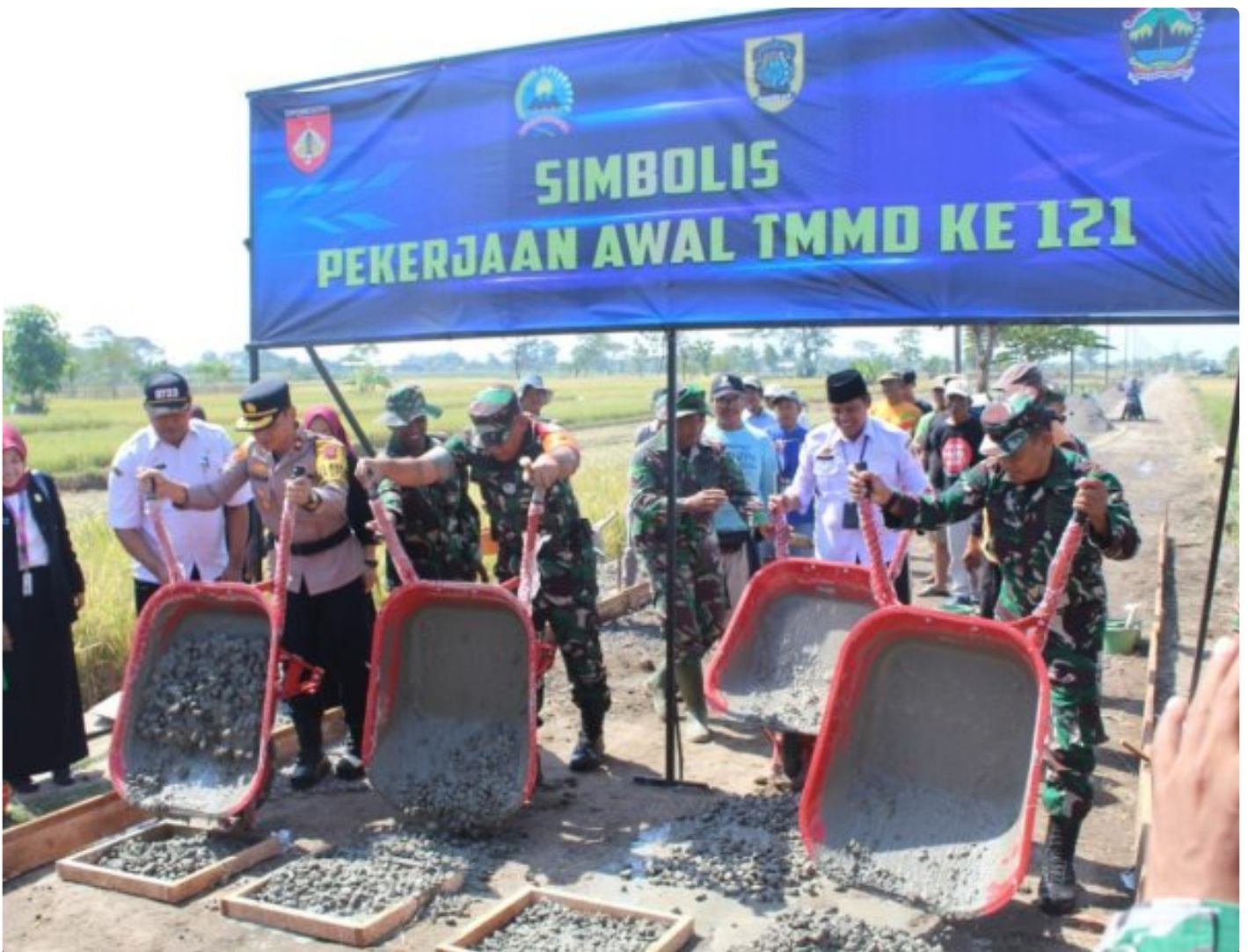
Pengecoran Perdana TMMD Reg 121 dilakukan Forkopimda Klaten
